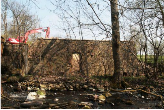
Grundmauern aus Feldsteinen waren sehr solide.
